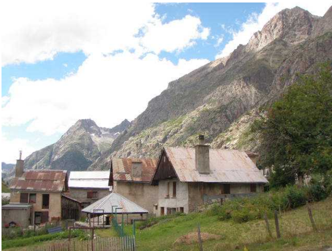
村の民家・屋根はトタン葺きである
