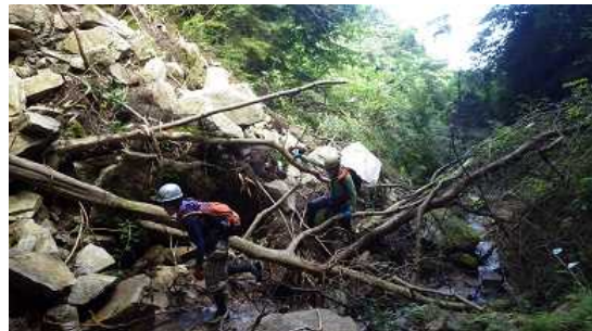
崩壊したところがヶ所あった
